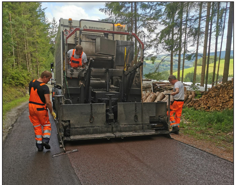
Die Firma Possehl beim Auftragen des Reparaturbelages
